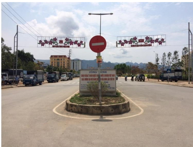
Công trình đường Chi Lăng kéo dài tại Thành phố Hòa Bình
